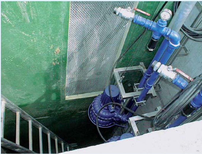
TAUCHMOTORVERDICHTER TMV: zur Belüftung biologischer Kläranlagen
